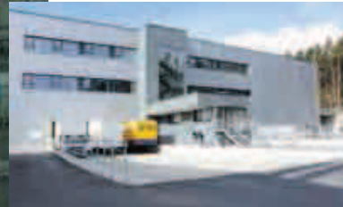
Materialwirtschaftszentrum: von der Zufahrtsseite mit Warenannahme und LKW-Anlieferung.
