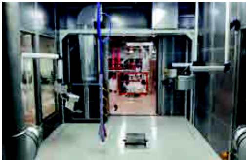
Rollenprüfstand für Motorräder - Fahrtstest inkl. Wärmerückkopplung
