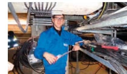
Sebastian Brunner, Facharbeiter beim Verlegen der Kabel über Steigtrassen und Kabelwannen.
