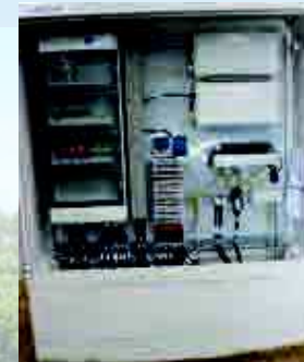
Außenverteiler für ein Schrankensystem
